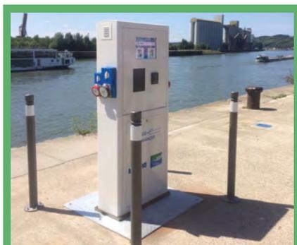
Service mis en place par HAROPA PORT | Paris de bornes électriques pour les bateliers permettant de réduire les pollutions atmosphériques liées à l'usage de groupes électrogènes lorsque les bateaux sont à quai, mais aussi de diminuer les nuisances sonores et olfactives.
