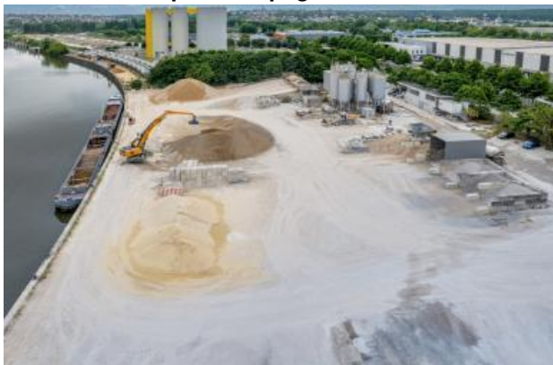
Béton responsable : Heidelberg Materials France et SFB misent sur le recyclage total de l'eau
